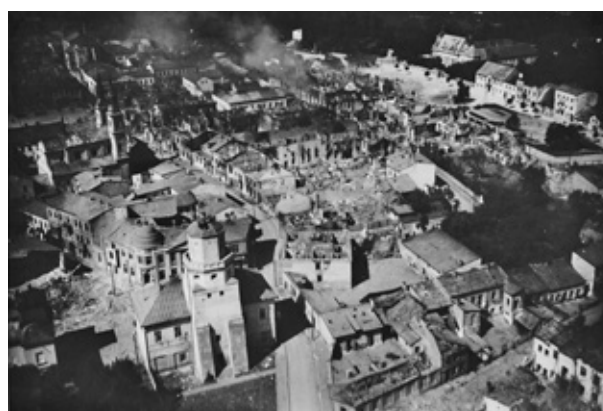
Zerstörung der Stadt Wieluń am 1. September 1939. Der erste Luftangriff des Zweiten Weltkriegs
