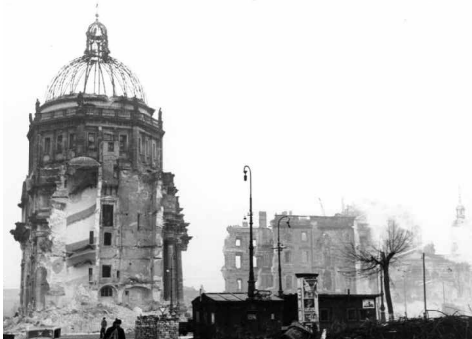
Abriss der Ruine des Berliner Stadtschlusses.
